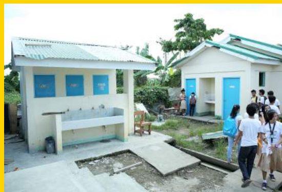
Op de San Jose National High School zijn de toiletten en wastafels weer in gebruik.
